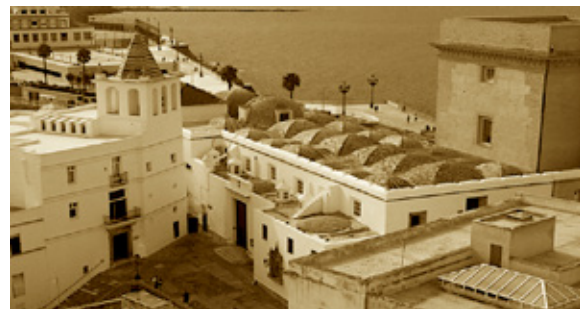
Foto nº 8 cubiertas de la catedral Vieja con sus bóvedas esquifadas recubiertas de cerámica trianera.
